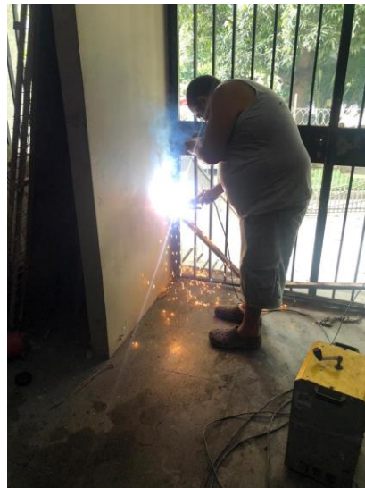
Figura 1: Portão de entrada ao interior do prédio da UniverCidade pela Av. Eptácio Pessoa
